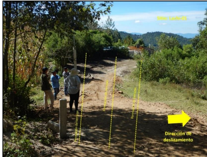
Fotografía 2.8. Sitio Lachi-01 donde se tiene la formación de terrazas con posibilidad de deslizamiento en la Agencia Municipal de Sitio Lachidoblas (al fondo se observa la vivienda con posibilidad de ser afectada).
