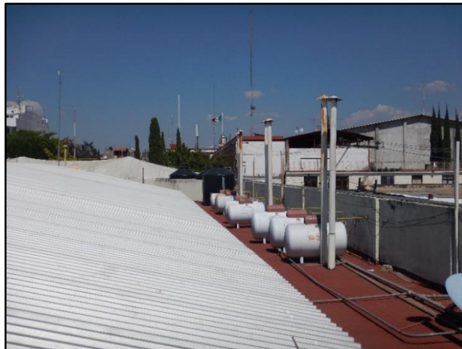
Fotografía 2.59. Ubicación (parte sur) de tanques con Gas LP en la azotea del mercado municipal.
