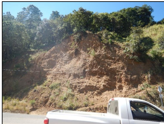
Fotografía 2.69. Características geológicas aledañas a la zona de posible afectación.
