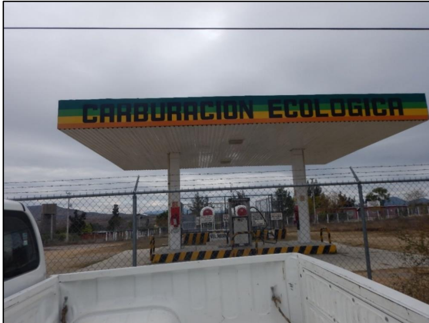
Fotografía 2.32. Estación de Gas LP revisada durante los trabajos en el Municipio de Miahuatlán de Porfirio Díaz.
