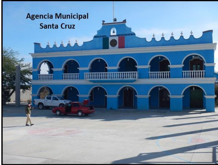
Fotografía 2.1. Palacio de la Agencia Municipal Santa Cruz, donde se tienen afectaciones por sismos.
