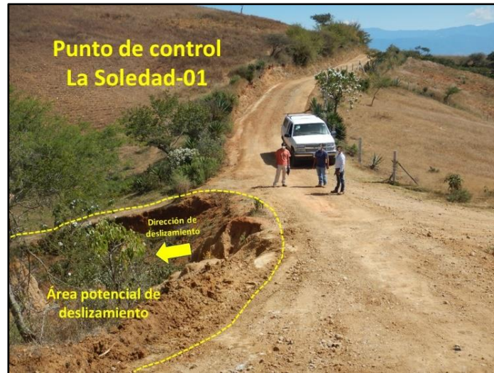
Fotografía 2.14. Sitio de Control Geológico La Soledad-01 con posibilidad de deslizamiento por apertura de vías de comunicación.
