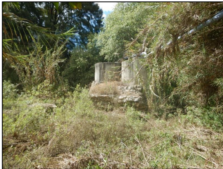
Fotografía 2.31. Condiciones actuales y de operación de la Galería Filtrante El Gexe.
