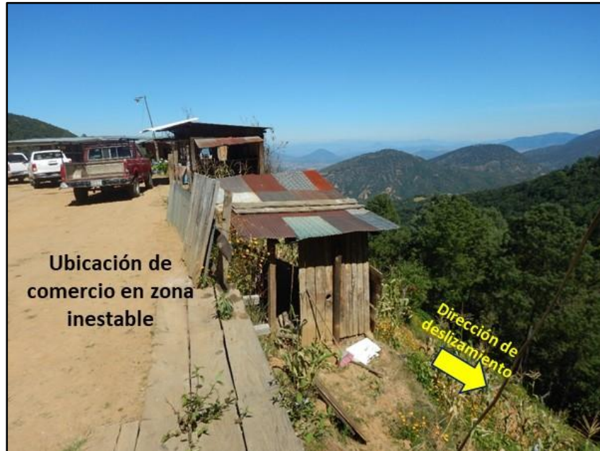
Fotografía 2.11. Sitio Roatina-01 con posibilidad de deslizamiento.
