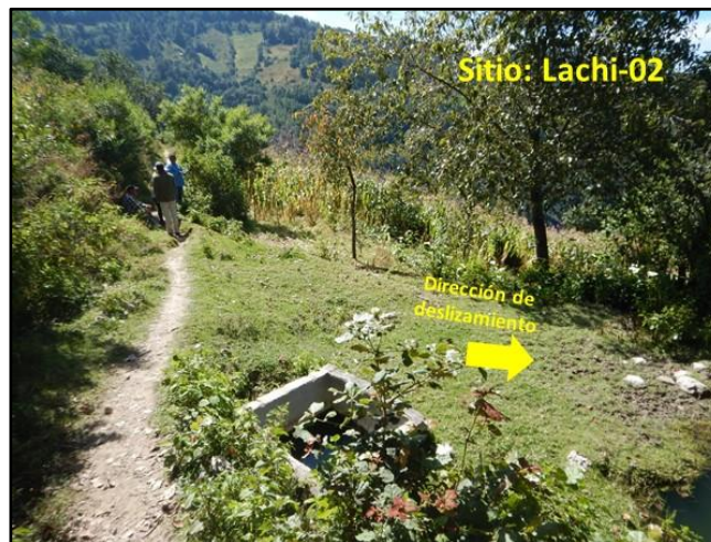
Fotografía 2.9. Sitio Lachi-02 donde se tiene la formación de terrazas con posibilidad de deslizamiento en la Agencia Municipal Sitio Lachidoblas.
