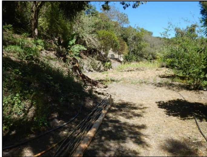
Fotografía 2.74. Sitio considerado como receptor de material con posibilidad de deslizamiento.
